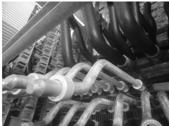
Figura 3: Mandril con Anillo Bipartido y Tapón
